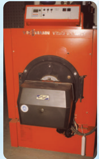
Abb. 5: Weber-Isis®-Universal-Aktivator: Montage an der Heizung im Keller (Ölleitung)
